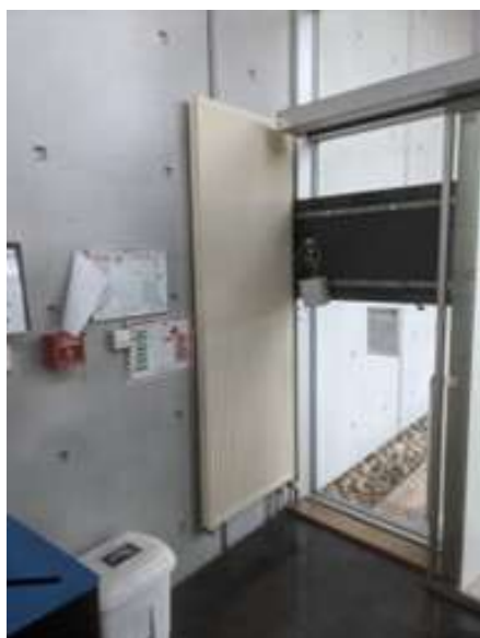
Radiateur eau chaude à déposer (B12001 « hall d'entrée »)
