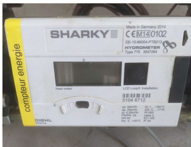
Comptage calories (SHARKY 775 DN65) situé dans la sous-station sur le réseau de chauffage primaire
