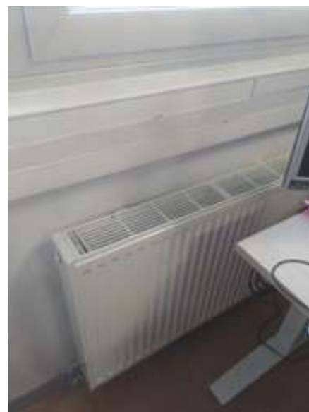
Radiateur eau chaude à déposer / déposer (B12007 « bureau »)
