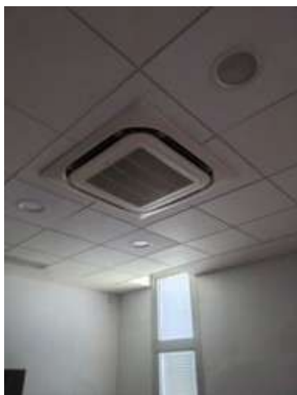
Cassette et grille de soufflage ventilo-convecteur à déposer (B12030 « salle informatique »)
