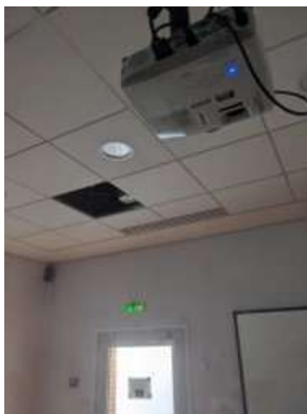
Grille de reprise ventilo-convecteur à déposer (B12030 « salle informatique »)
