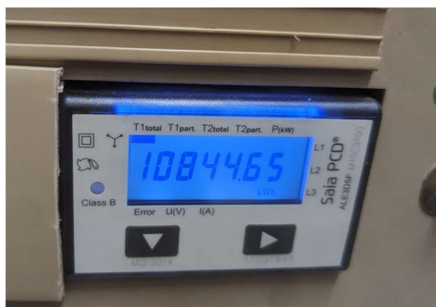
Comptage électricité de la CTA (SAIA ALE3D5FM10C3A00) situé dans l'AD PRM
